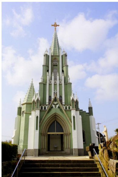
Fachada de la Iglesia en Hirado
